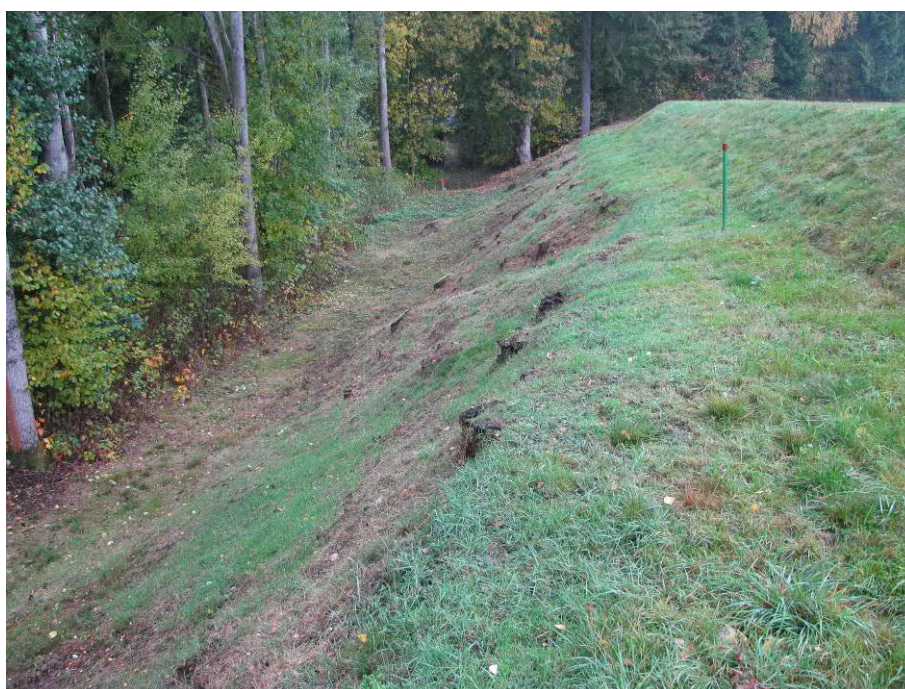
Obr.2 - pohled na vzdušní líc s přítěžovací lavicí
