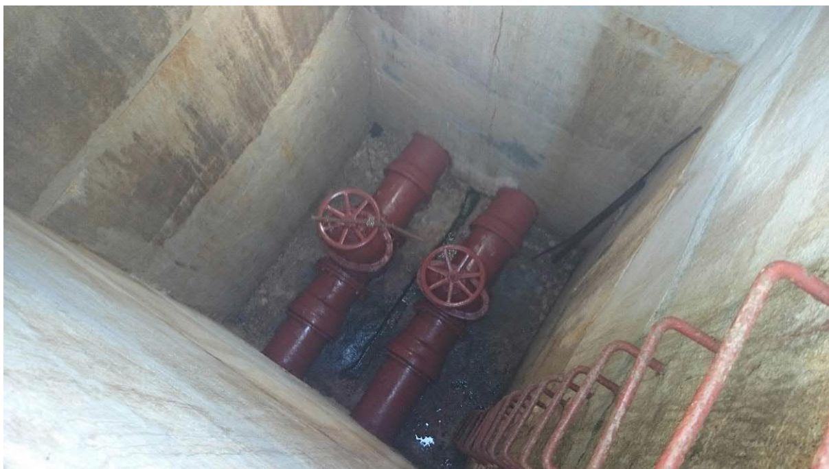
Obr.7 - pohled do povodňá šachty s dvěma regulačními šoupaty DN 400
