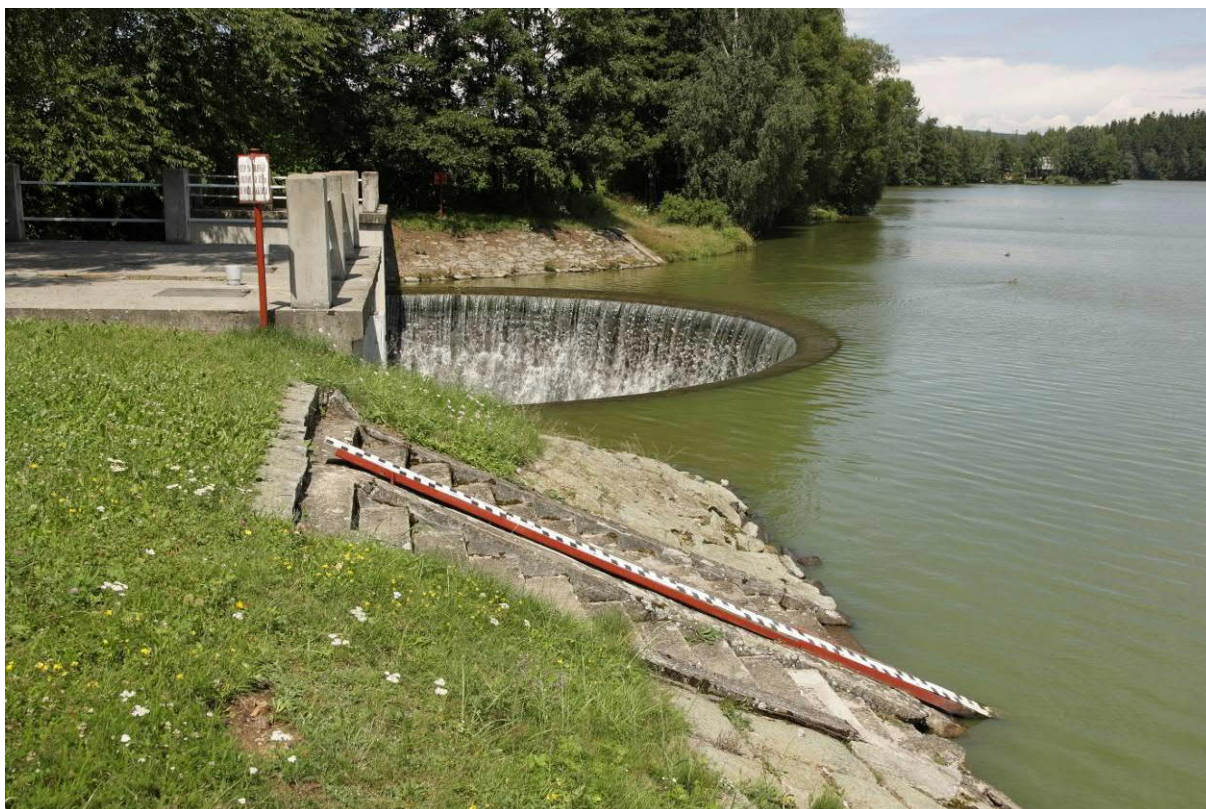
Obr.5 - pohled na bezpečnostní přeliv VD Strž
