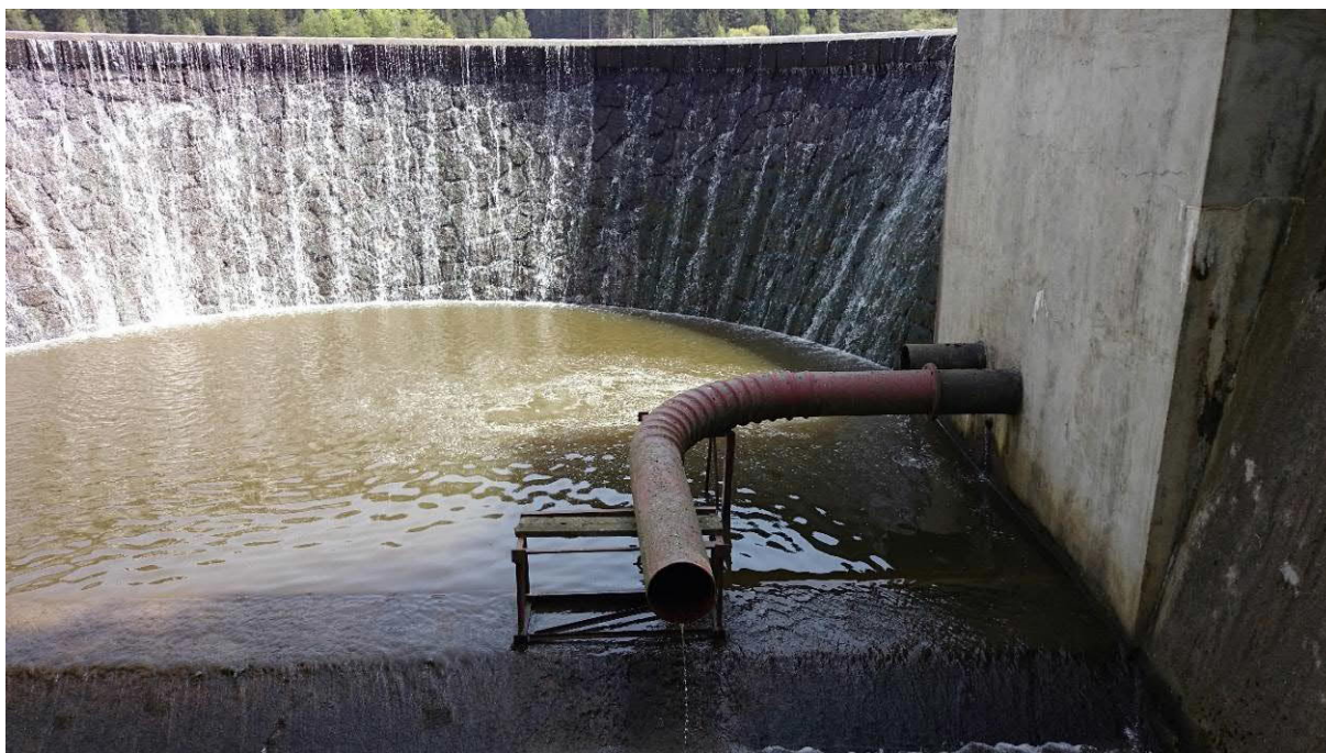
Obr.6 - pohled na vývar s vyústěním spodních výpustí
