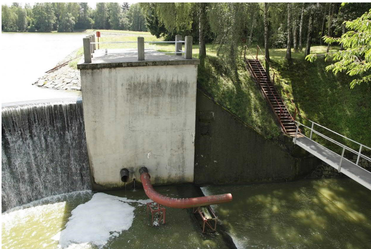
Obr.10 - pohled levý pilíř přelivu s výpustným potrubím, ocelovou lávku a schodiště a místo na levém břehu vývaru určené k umístění zařízení staveniště
