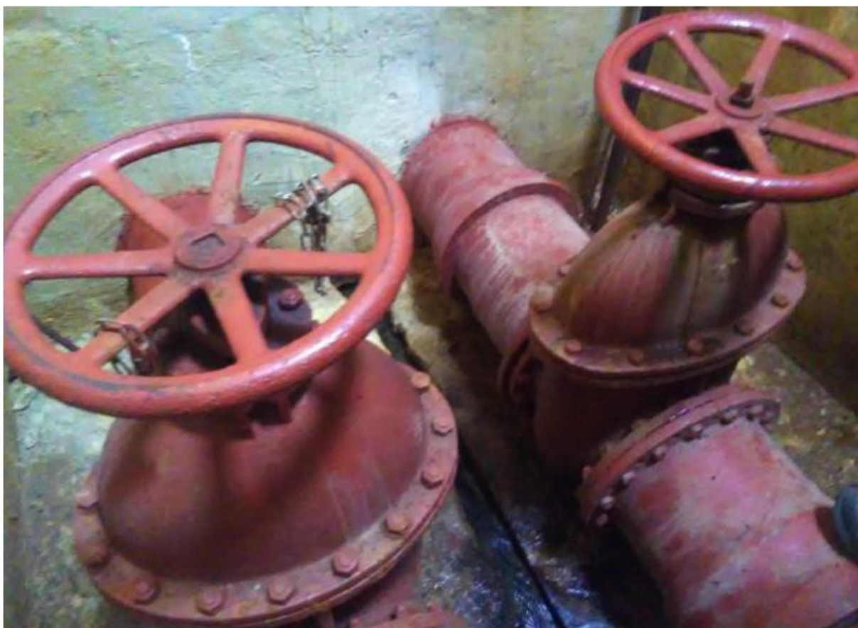
Obr.8 - detailní pohled na dvě regulačními šoupaty DN 400
